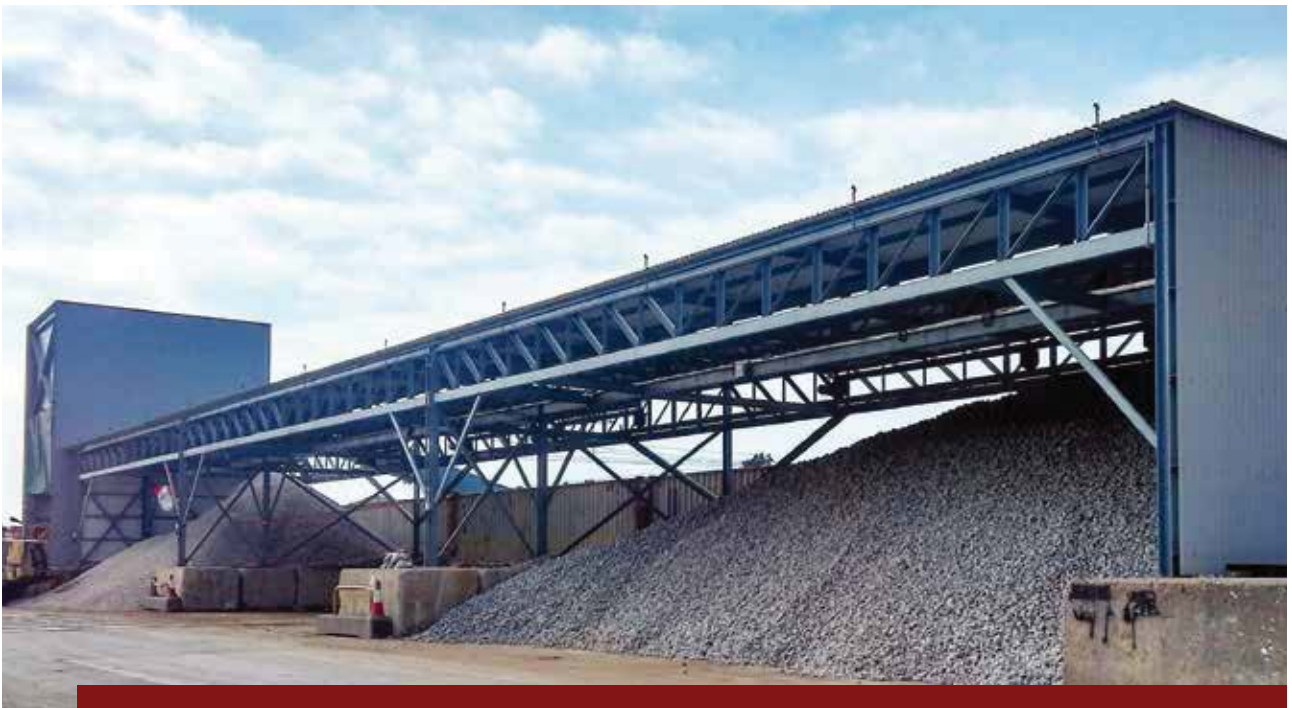
友盟新增之石料倉庫乃全港各建築地盤的主要石料供應中心。
