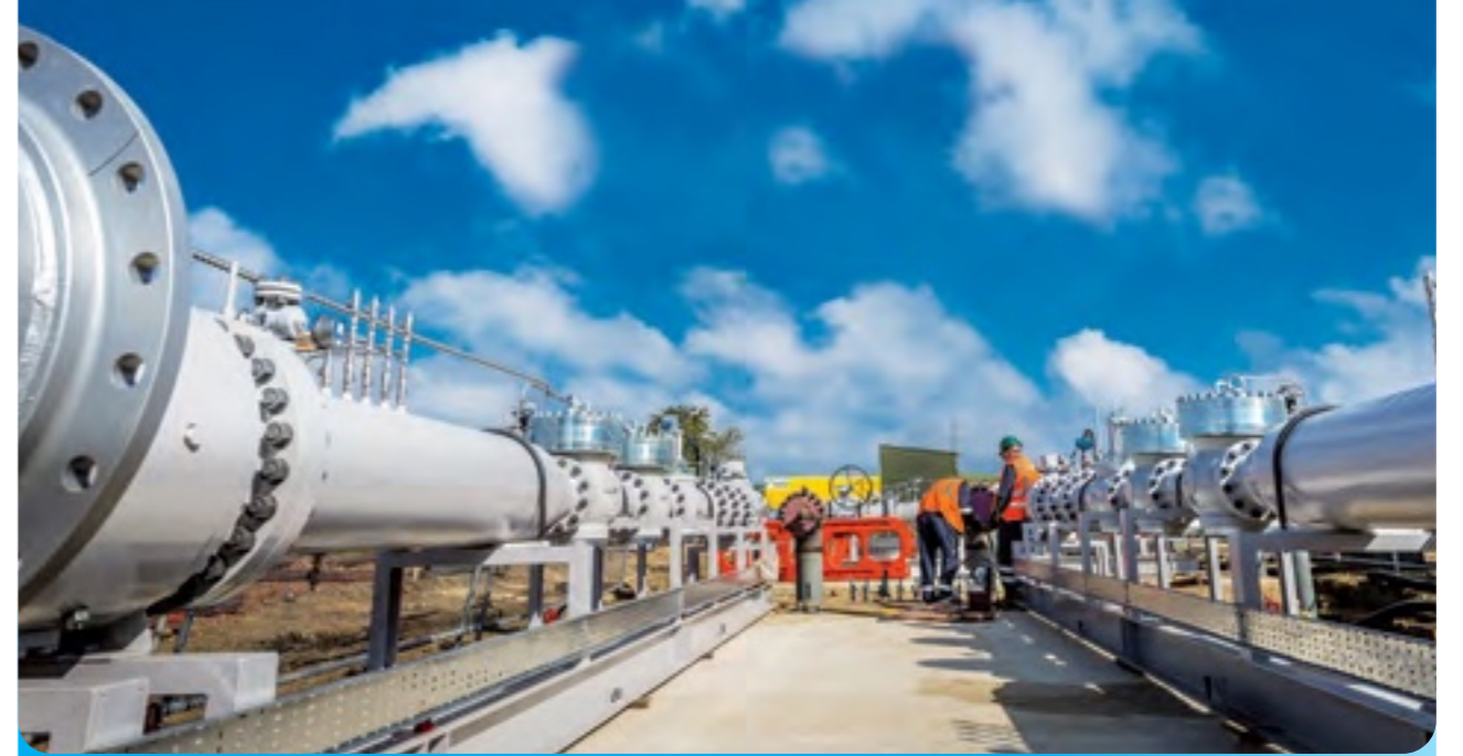
根據新規管期內的業務計劃，Northern Gas Networks 將為天然氣網絡作出超過十八億英鎊的投資。
