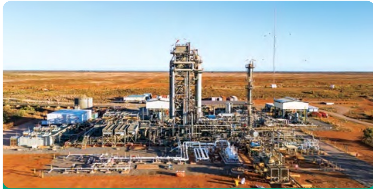
Dampier Bunbury Pipeline 的 Tubridgi 儲氣設施擴建工程已完成，產能提升，為市場提供額外天然氣供應。
