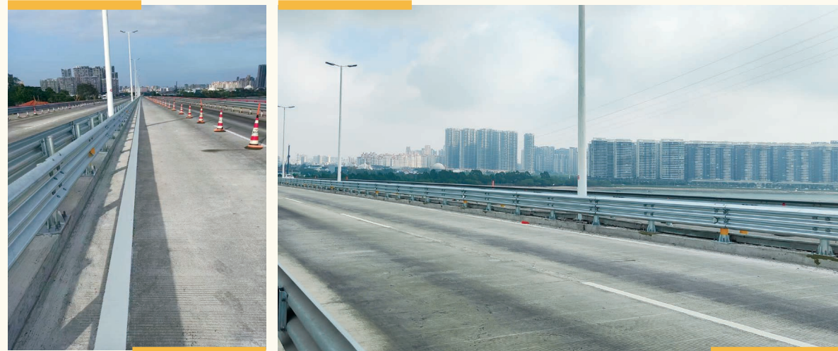
汕頭海灣大橋將其波形樑護欄升級為三道樑安全護欄，提供更佳的防撞保護及安全。
