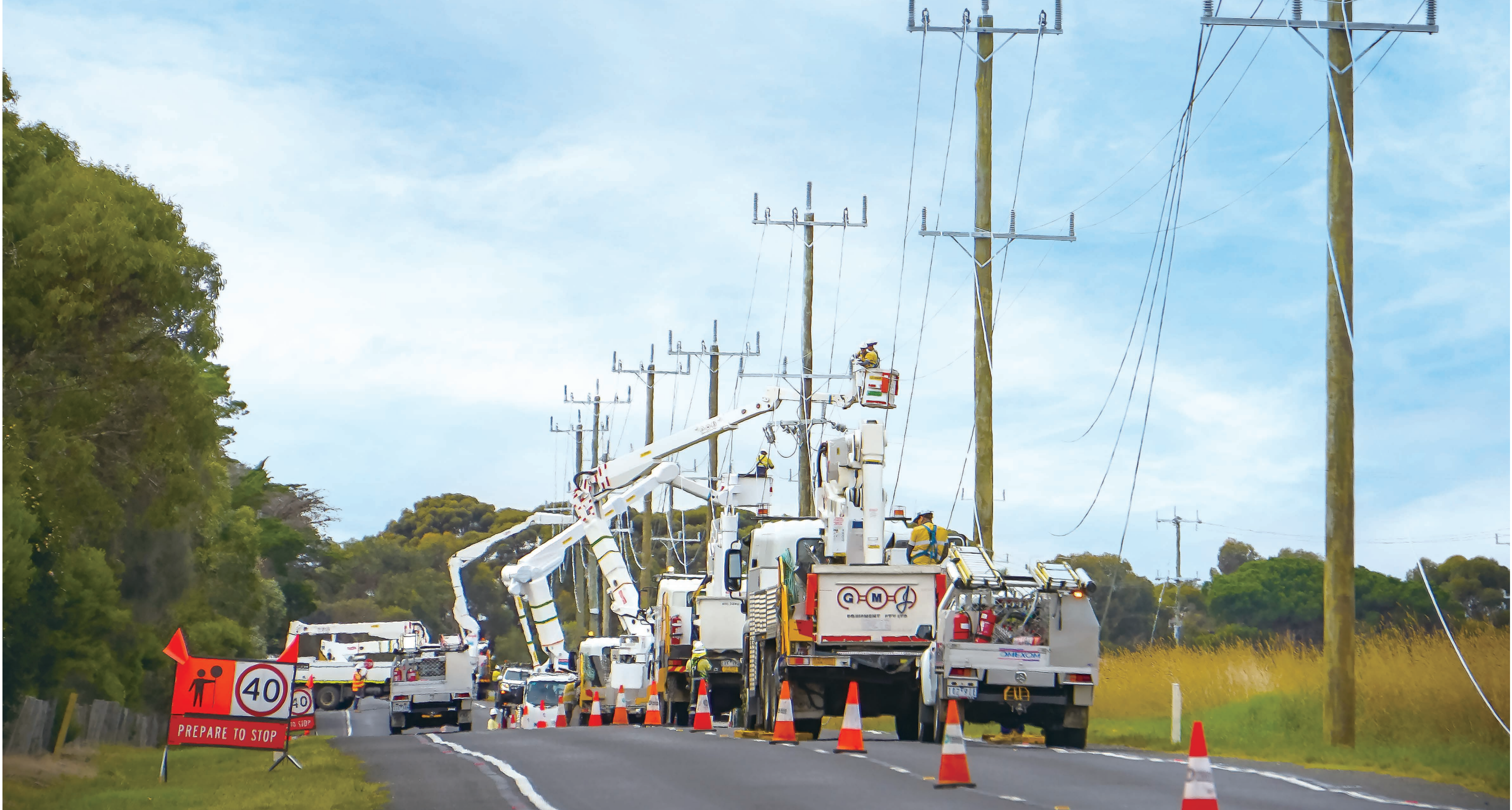
Victoria Power Networks 場地管理團隊升級架空電纜，以減少澳洲西部維多利亞地區發生叢林大火的风险。
