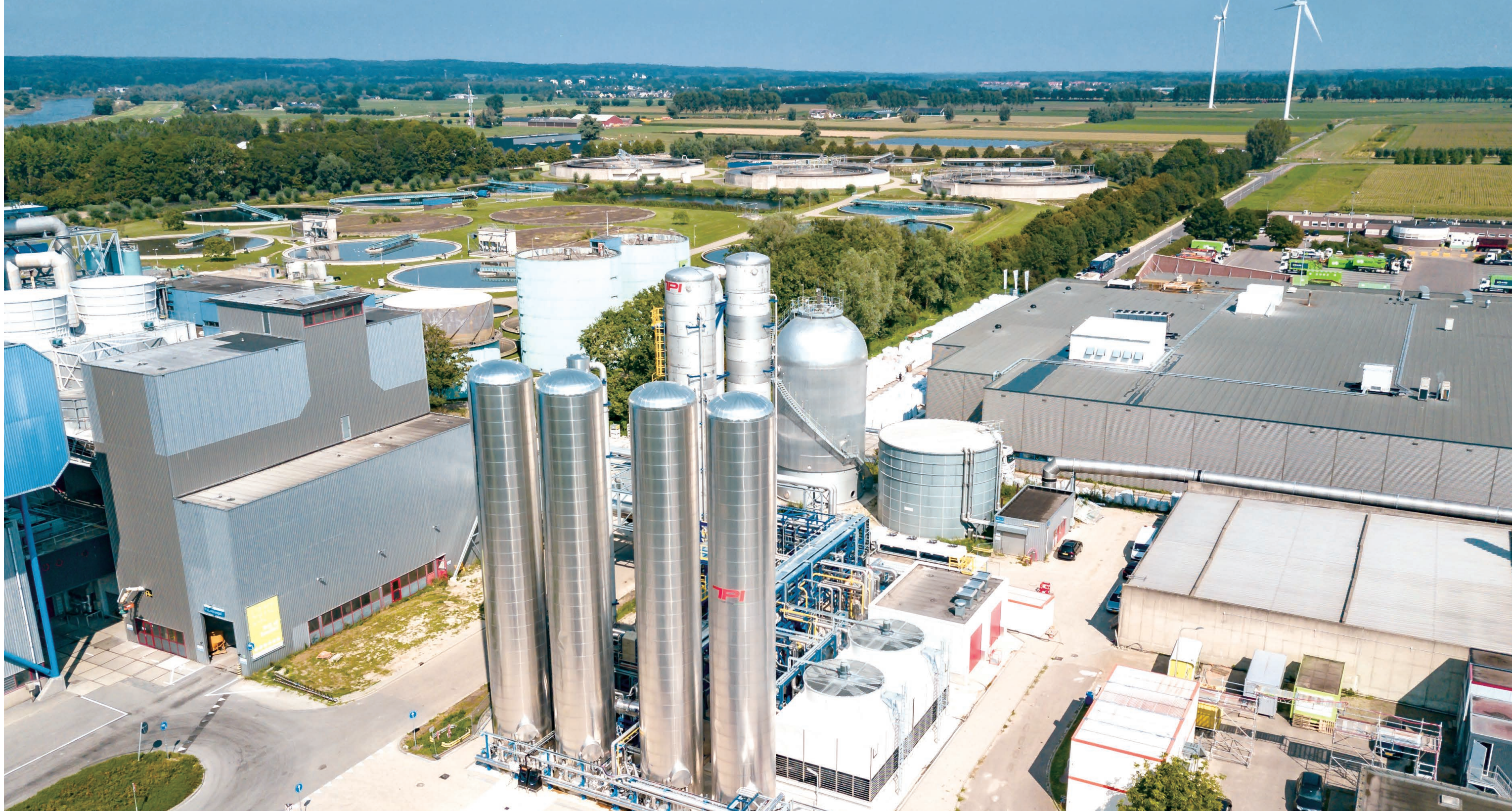
AVR – 設於德伊芬（Duiven）專為收集二氧化碳之廠房，用作收集二氧化碳以供溫室重用（碳收集利用）。
