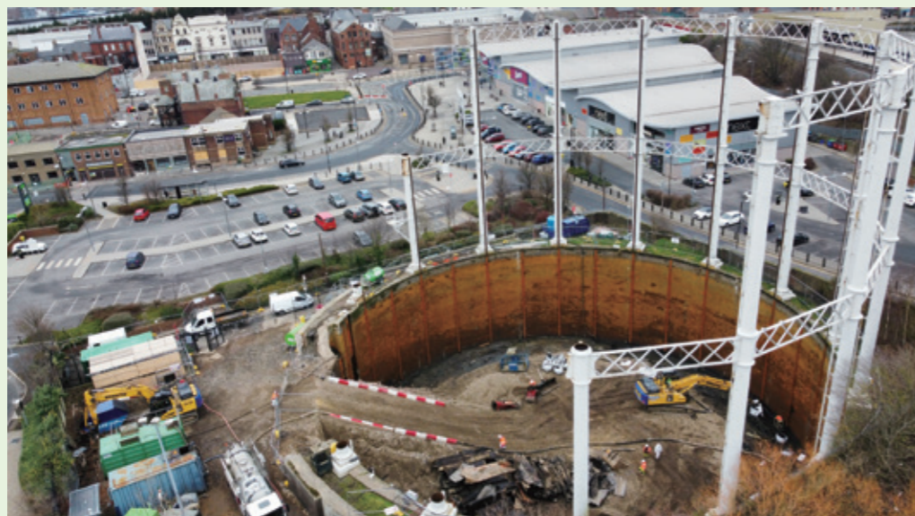
NGN South Shields 燃氣儲槽拆除工程，圖片由 Erith Ltd 提供。
